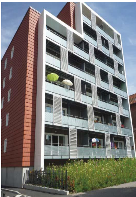
Saint Die des Vosges Logements, R+7 CLT et poteaux LC
