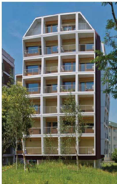
Maison de l'Inde , Paris Logements Etudiants, R+7 Poteaux/Poutres LC/ plancher CLT/ Noyau Béton
