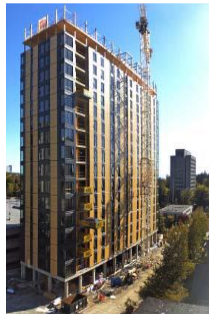
UBC Brocks Commons, Vancouver, Canada Résidence Etudiants, R+17 Structure Poteaux/Poutres LC / Plancher CLT
