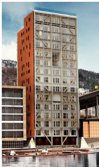
Treet Tower, Bergen, Norvège Logements, R+13 Modules Préfas et Exosquelette
