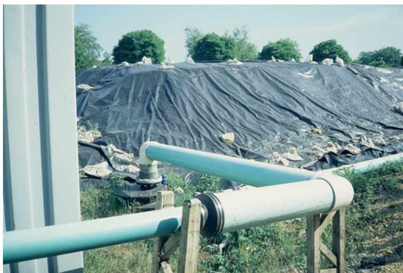
Traitement par biodégradation de terres polluées par des HAP, disposées en andains de 100 à quelques centaines de tonnes, sur site © J. Berthelin
