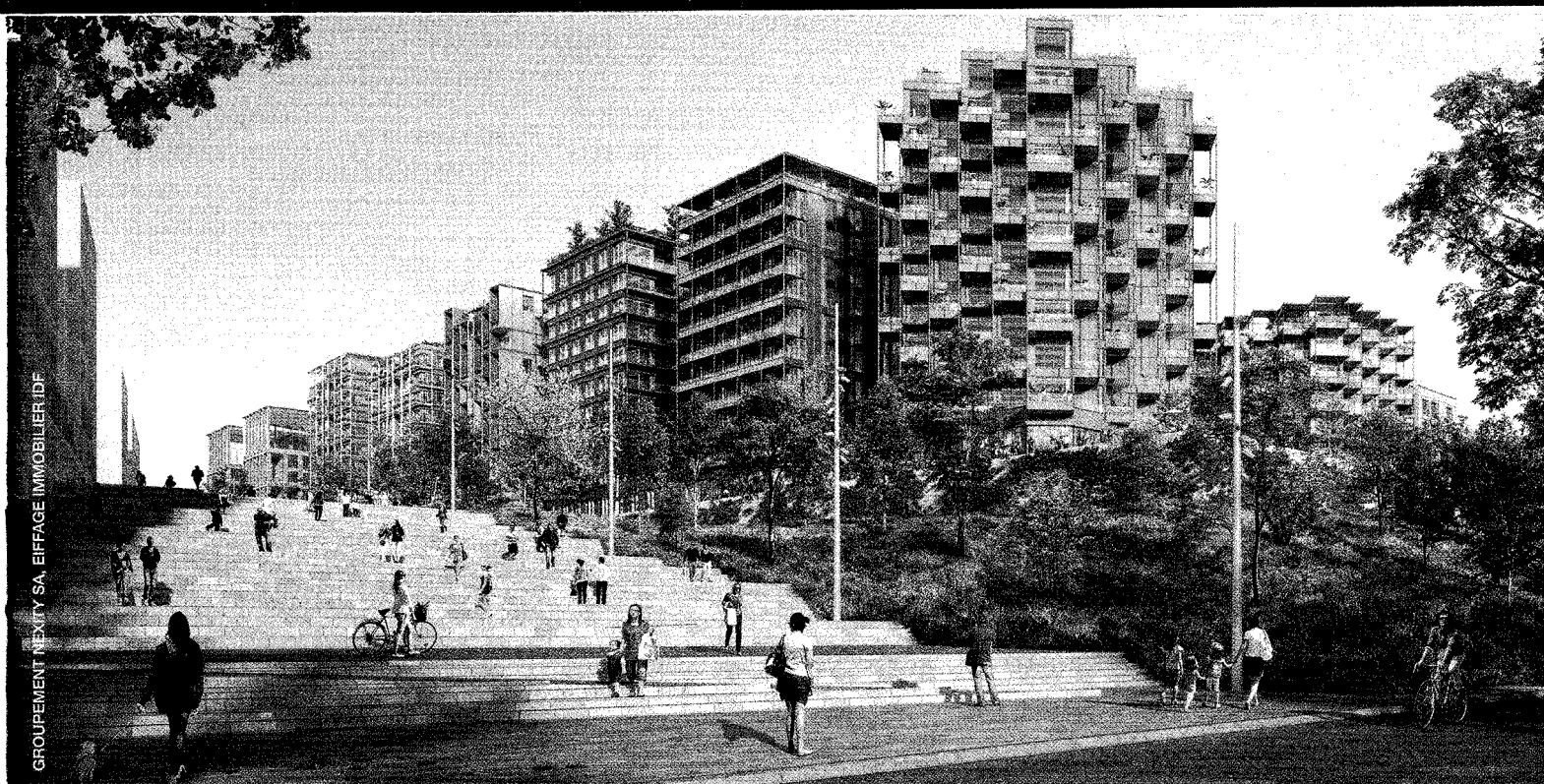
Le Lot E du Village des athlètes à Saint-Ouen. Les immeubles inférieurs à 28m seront dotés de façades bois (FOB), avec une structure bois et des planchers collaborant béton. Le bois sera 100% français.
