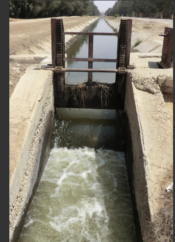
Porte régulant le flux d'eau
