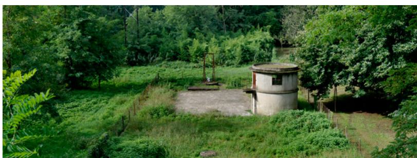
Figure 4. Station de captage d'eau potable entourée de son périmètre de protection - © Laurent Mignaux/METL-
