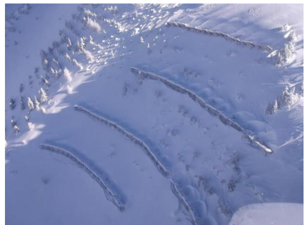
Figure 2. Protection contre les avalanches (Isère) - (photo ONF)
