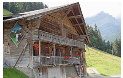
Figures : 5 Maisons à pan de bois longs et courts du XVII ème à Rennes - 6 maison à pan de bois et briques Blois - 7 Maisons à pan de bois et mortier à Blois - 8 Chalet traditionnel dans les Alpes
