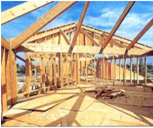
Figure 14. Maison à ossature bois (à gauche) et Figure 15. Maison bois à panneaux porteurs en sapin-épicéa, et exemple de panneau à gauche en pin (à droite)
