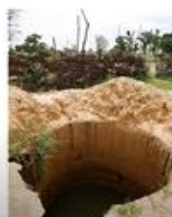
Céramique sur le point de s'effondrer
